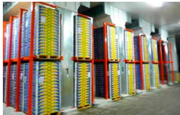
Figura 4. Dei pre-raffreddatori a flusso d'aria verticale riducono i tempi di pre-raffreddamento, aumentando la durata di conservazione e migliorando la qualità dei prodotti ortofrutticoli, e consentono un risparmio dei costi energetici.
