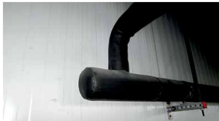
Figura 12. Isolamento dei tubi in buone condizioni.
